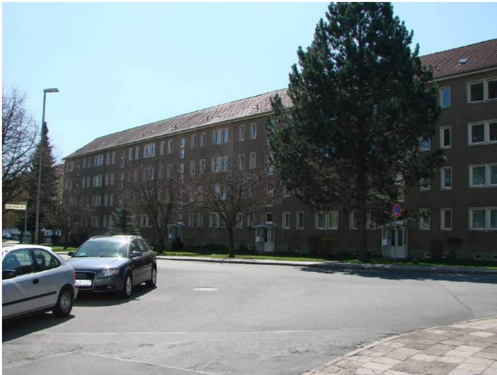
Abbildung 36: Freiheitsstraße 3-8 leerstehend, zum Rückbau vorgesehen, abgerissen
