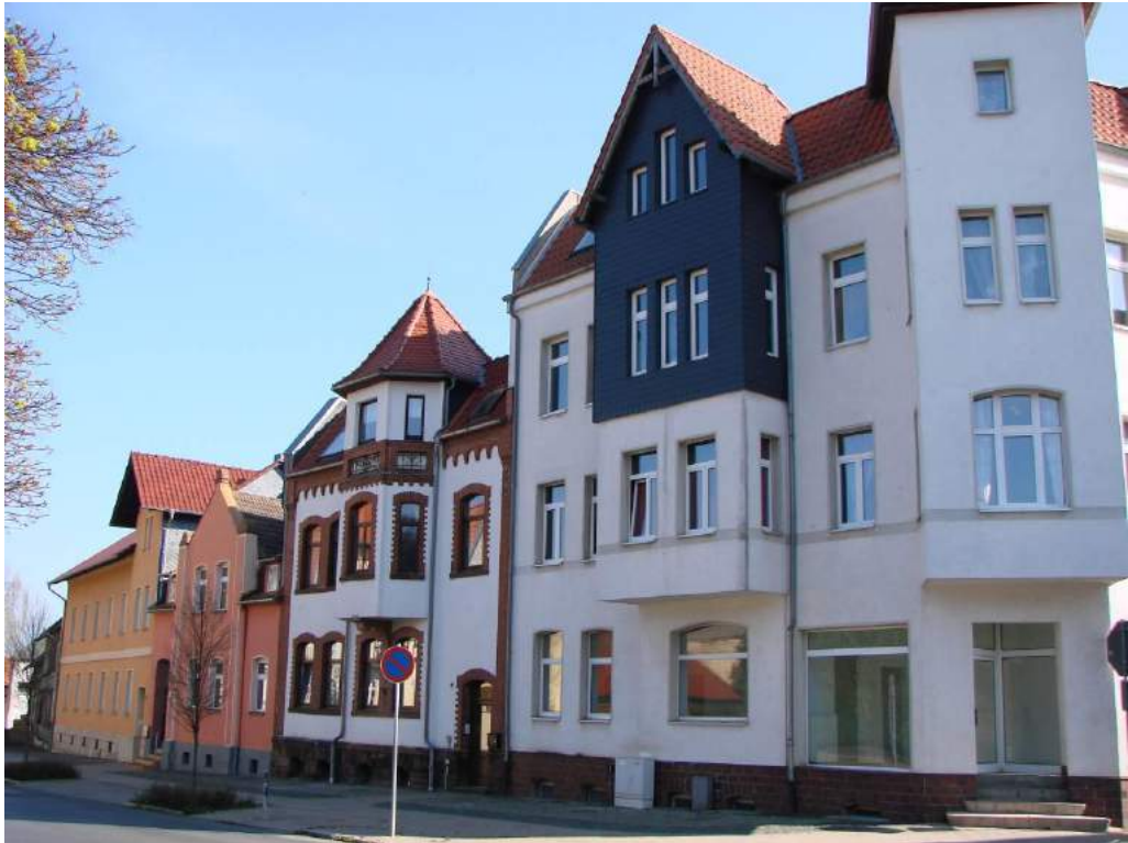
Abbildung 51: überwiegend energetisch sanierte Gründerzeitgebäude - Löwentorstraße
