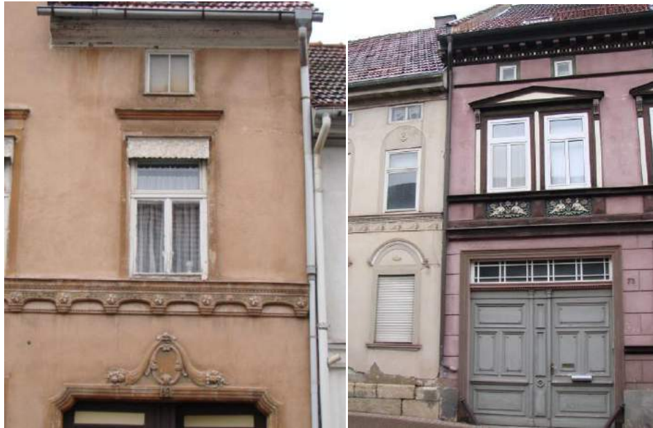
Abbildung 43: Putz- und Stuckdetails der Gründerzeit auf verputztem Fachwerk rechts Einzeldenkmal Bahnhofstrasse 73
