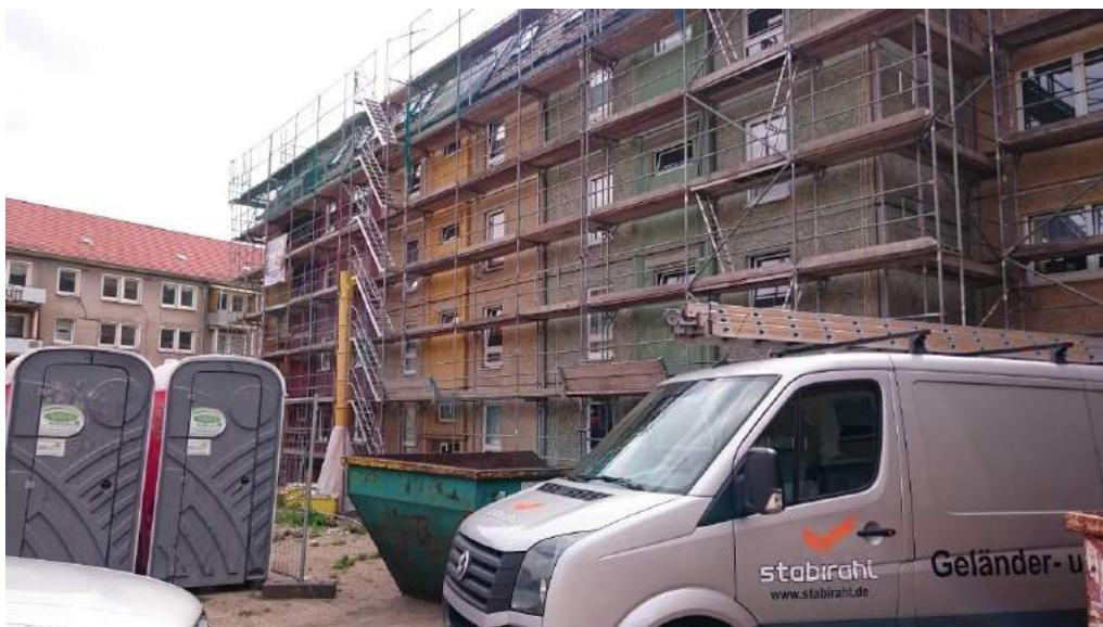
Abbildung 95: Sanierungsobjekt der WBG Südharz im Wohngebiet Mitte Löwentorstraße 2-2b
