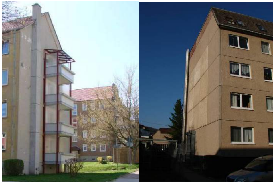
Abbildung 55: Blockheizkraftwerke im Plangebiet, links Anlage 2 Kätke-Kollwitz-Straße, rechts Anlage 1 Wallstraße
