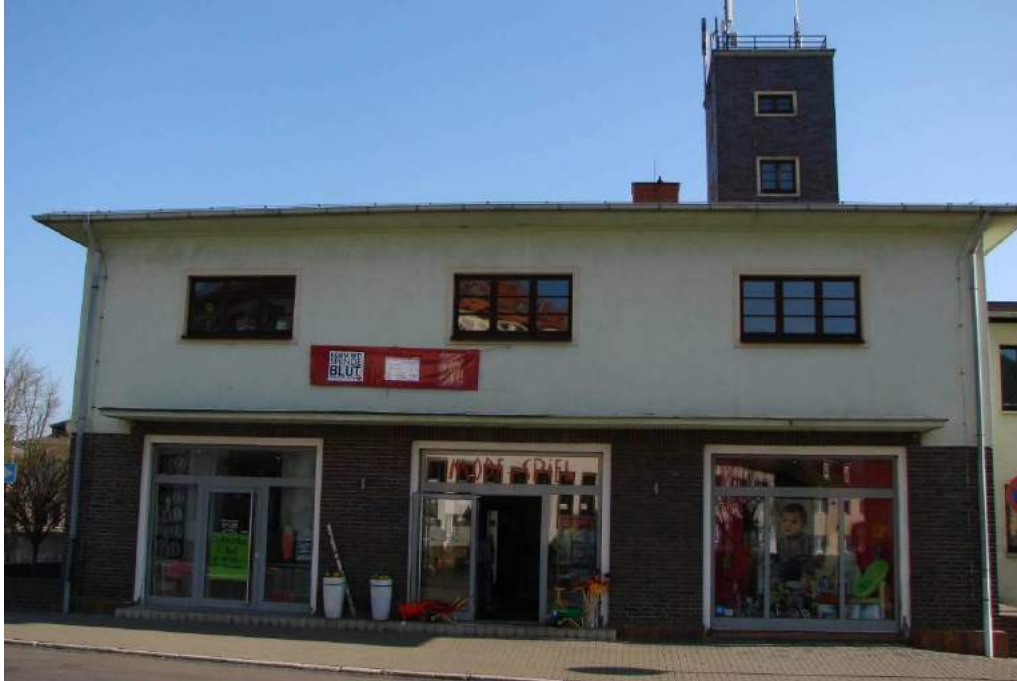
Abbildung 45: Fabrikgebäude Von Stein Str.8 Innenansicht
