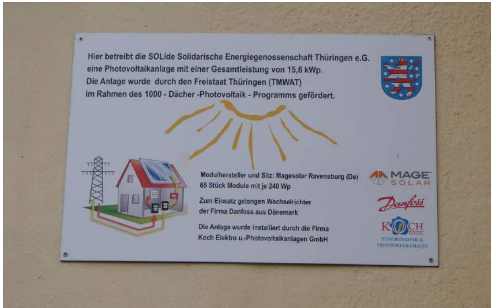
Abbildung 56: Kino Löwentorstraße 15, Dachflächenphotovoltaik
