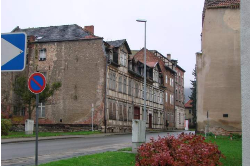
Abbildung 72: Gebäudenotstand in der Freiheitsstraße
