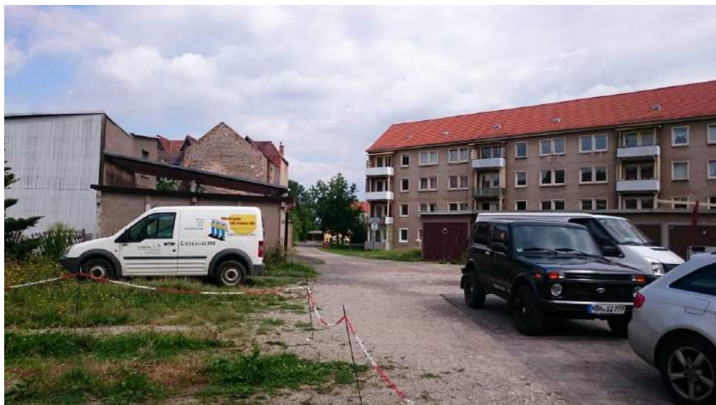
Abbildung 74: Parkierung und Garagenkomplexe hinter Blockbebauung Freiheitsstraße 3-8
