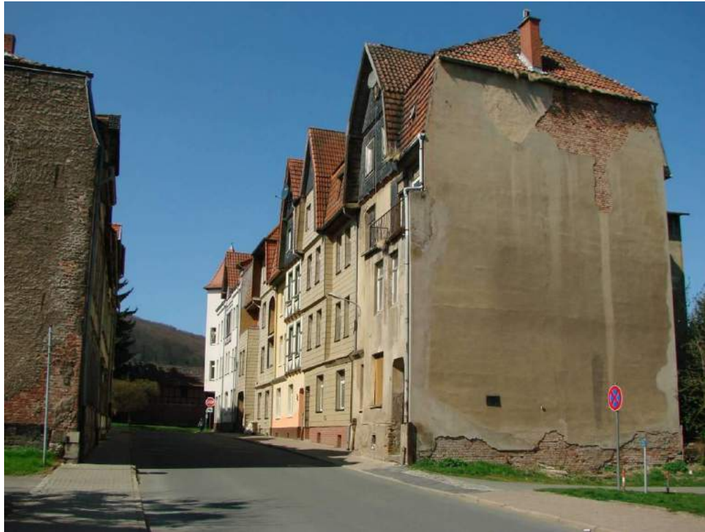
Abbildung 37: Mehrfamilienhaus - Gründerzeitbebauung Freiheitsstraße
