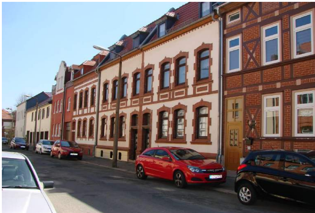
Abbildung 71: Gestaltete und aufwendig sanierte Fassaden der Brückenstraße
