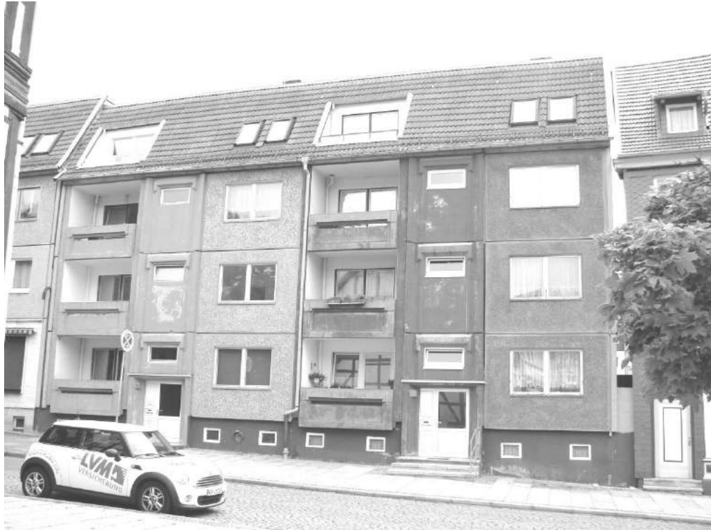
Abbildung 111: Heutige Situation des Gebäudekomplexes Löwentorstraße 1-1c
