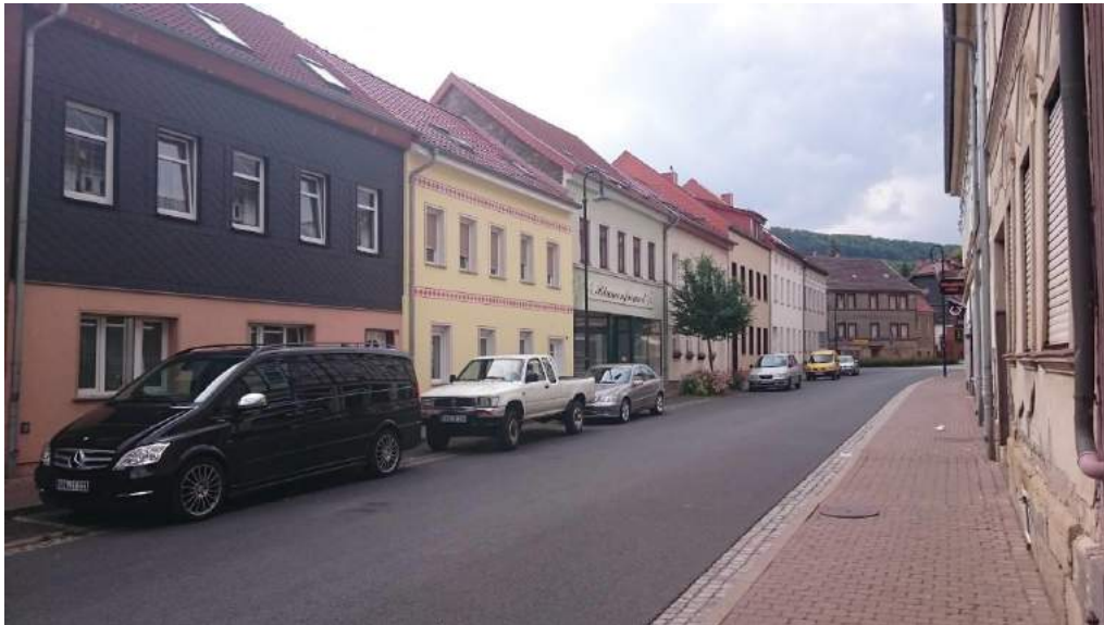
Abbildung 81: Bahnhofstraße mit den Gebäudetypen 2 und 3
