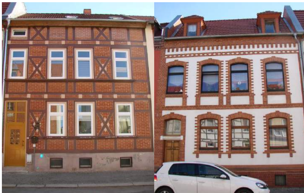
Abbildung 44: Putz- und Zierfassaden der Gründerzeit auf Massivmauerwerk in der Brückenstraße
