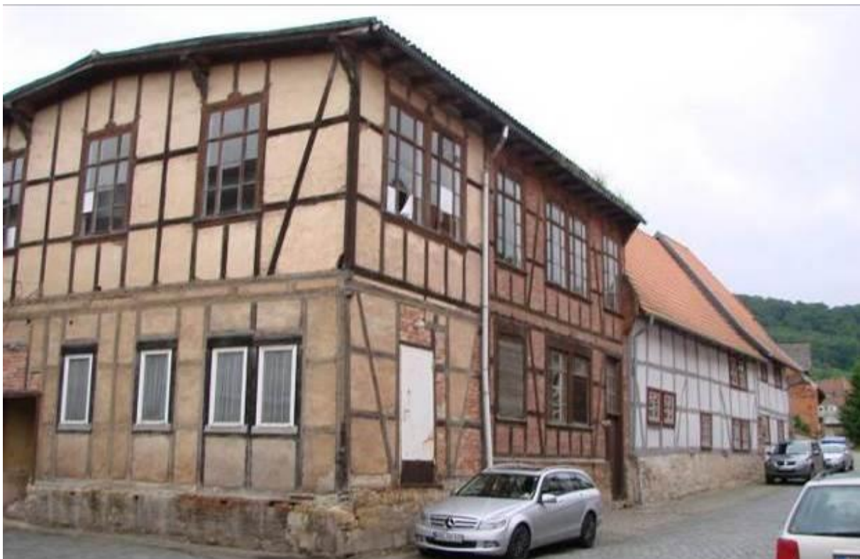
Abbildung 54: Industriezeitalter-Fachwerk, Hagenstraße (Quelle: Holz)
