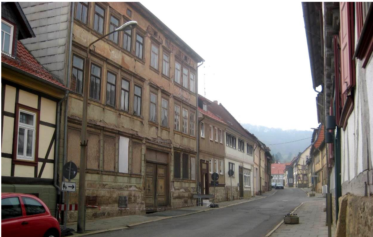
Abbildung 70: Typ 3, 3-geschossiges Fachwerkobjekt, Hauptstraße (Quelle: DSK)
