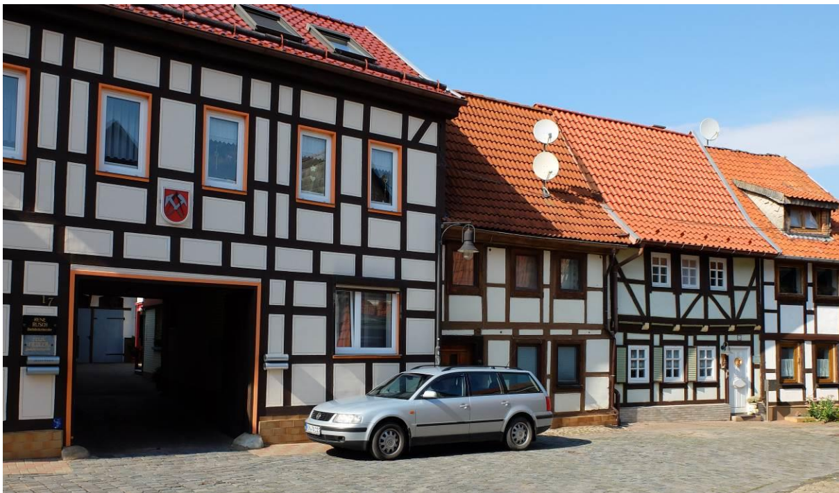
Abbildung 58: Fachwerk mit Putzfällung, Hagenstraße (Quelle: DSK)
