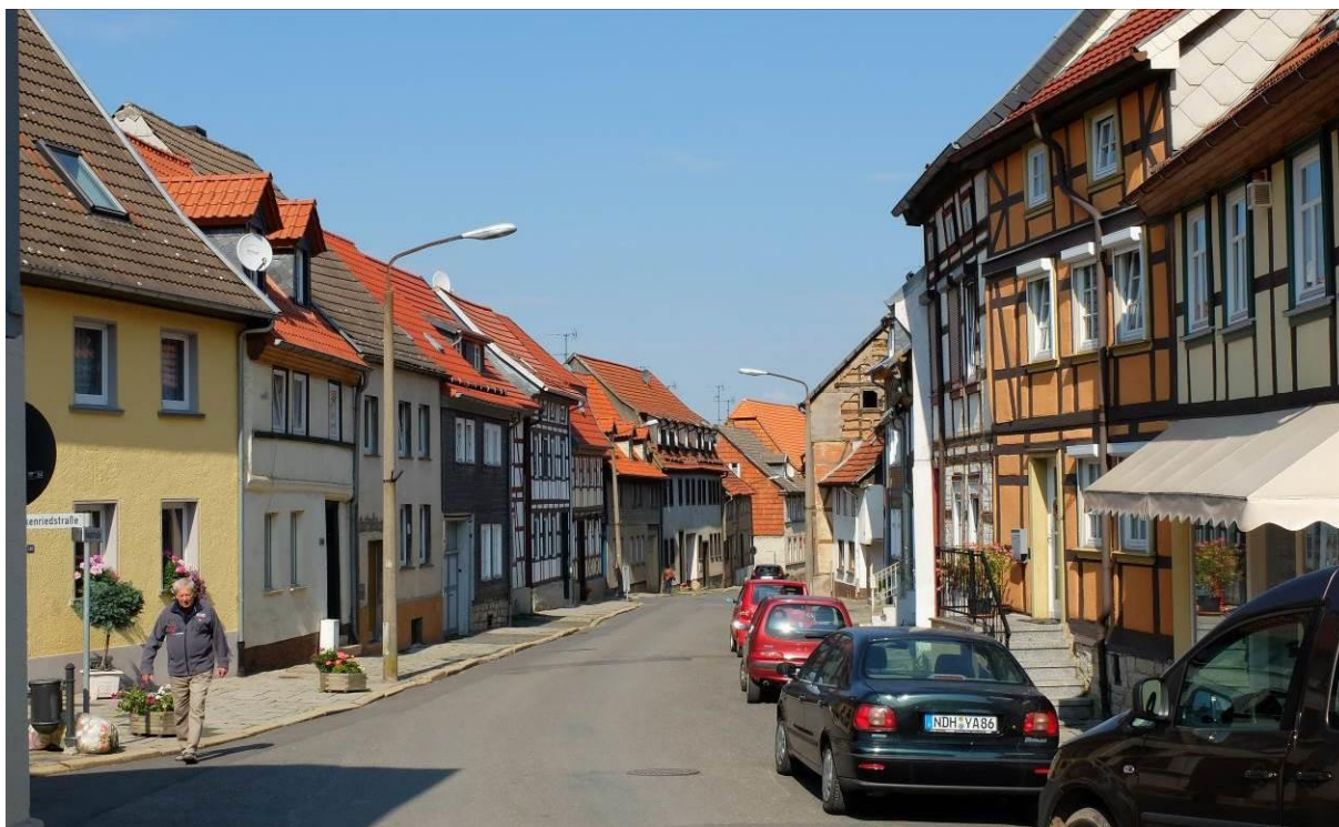
Abbildung 6: Oberstadt, Hauptstraße, Ecke Walkenriedstraße (Quelle: DSK)
