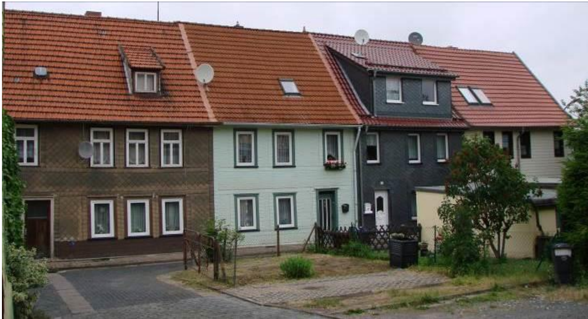
Abbildung 44: Oberstraße (Quelle: Holz)
