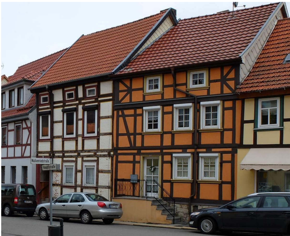
Abbildung 69: Fachwerkgebäude mit Drempelgeschoss (Quelle: DSK)
