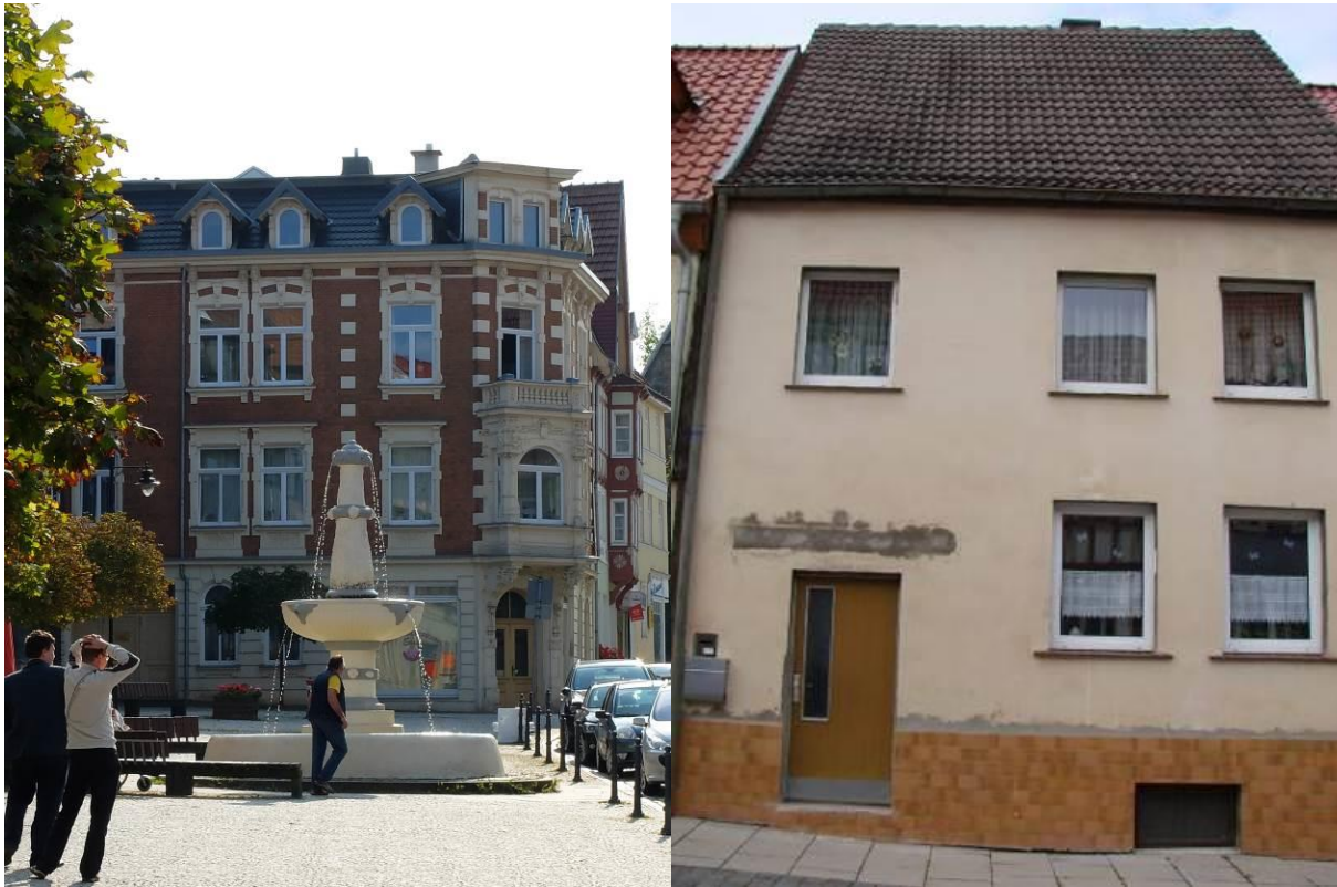
Abbildung 60: links: Massivbau, Putz-Zierfassade, Zierbrunnenplatz; rechts: Massivbau, Putzfassade, Hauptstraße (Quellen: Holz)
