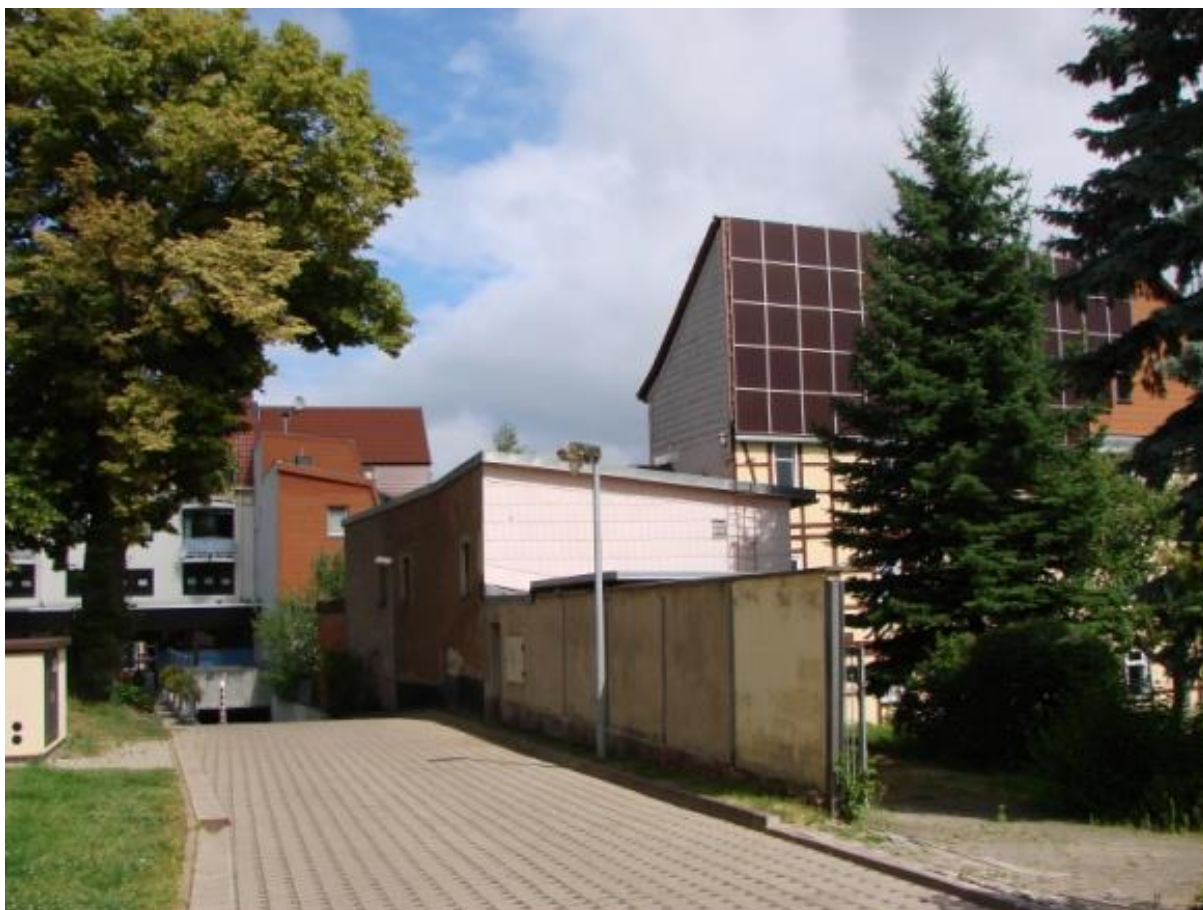
Abbildung 64: Rückseite Hauptstraße 71, Dachflächenphotovoltaik (Quelle: Holz)
