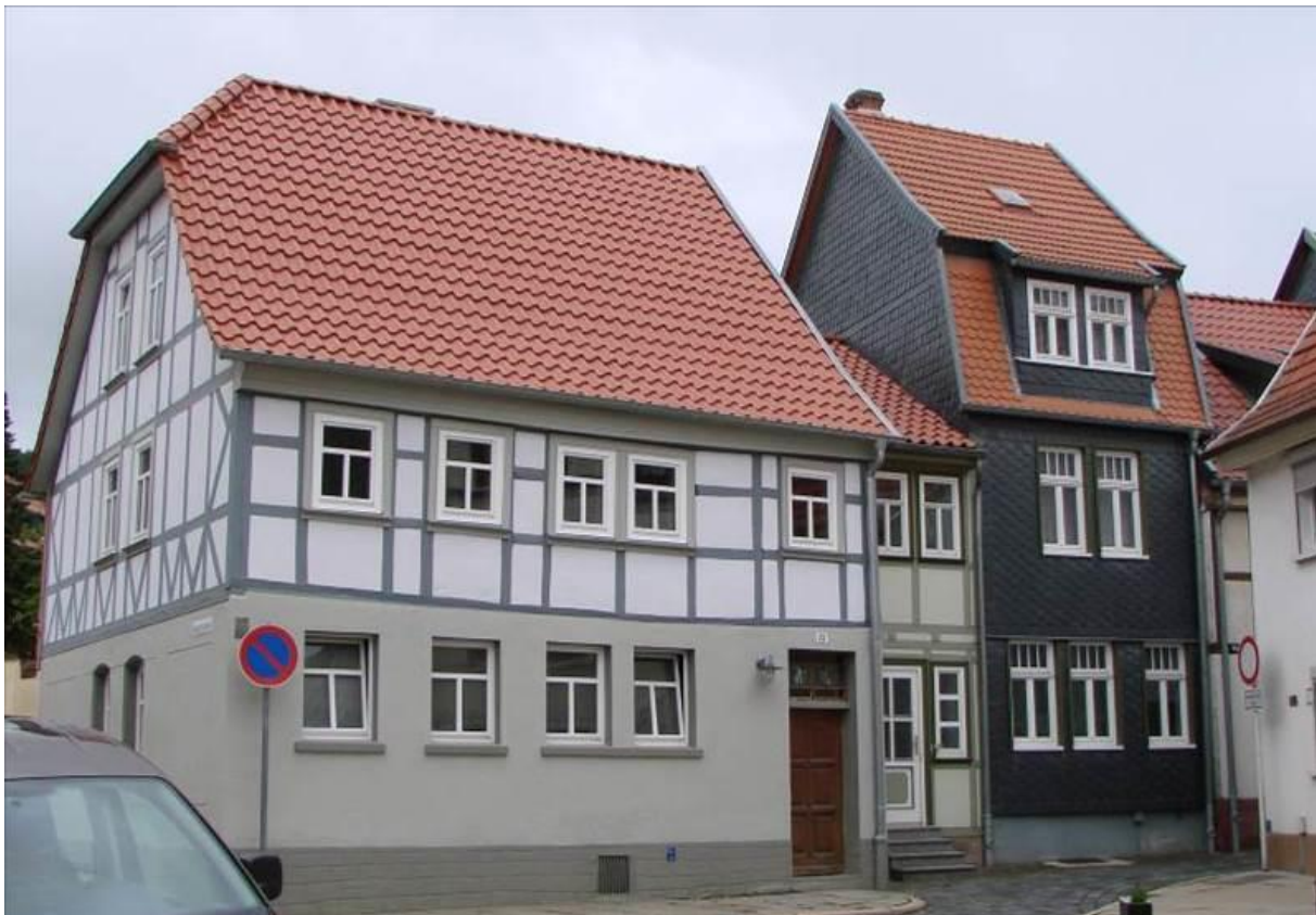
Abbildung 86: Fachwerkhaus, obere Hauptstraße (Quelle: Holz)
