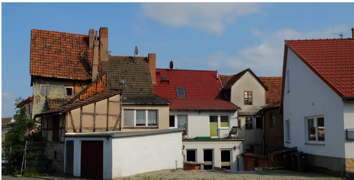
Abbildung 14: Mittelstadt, Rückseite Weberstraße bzw. Mauerstraße (Quelle: DSK)
