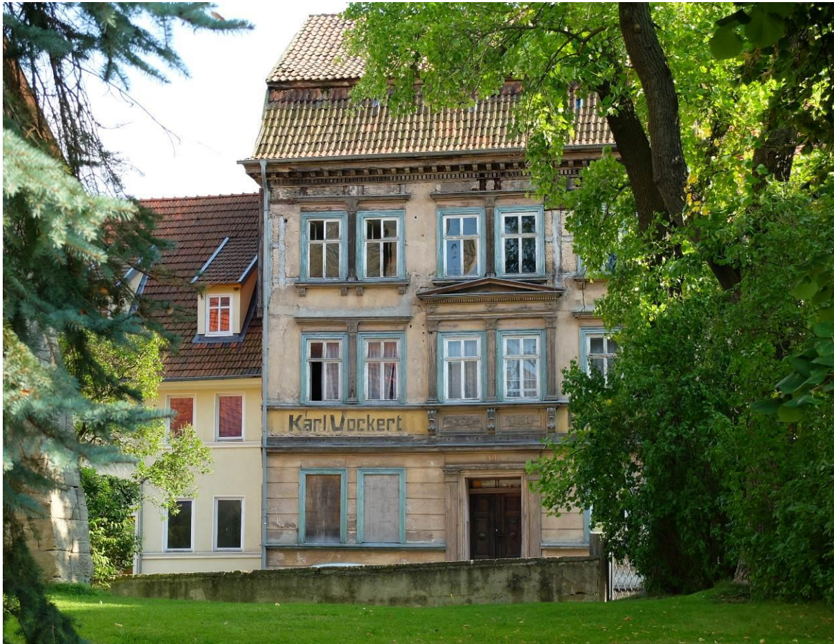
Abbildung 57: Fachwerk mit Putzzerlelemente, Neue Straße (Quelle: DSK)
