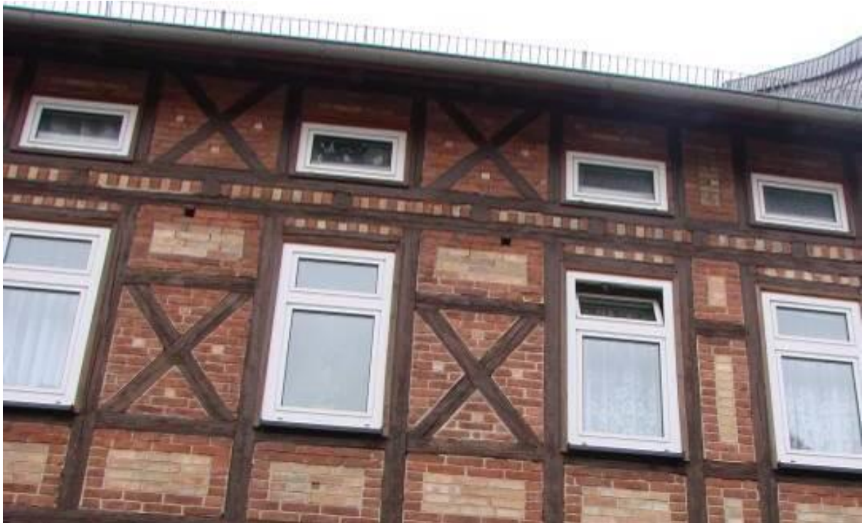
Abbildung 53: Fachwerkdrempel, ziegelschichtiges Sichtfachwerk, Oberstraße (Quelle: Holz)
