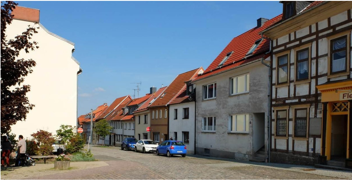
Abbildung 39: Neue Straße (Quelle: DSK)
