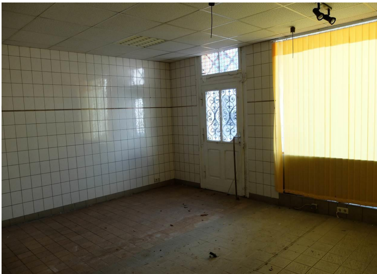
Abbildung 116: Impulsprojekt 2, frühere Wirtschaftsräume im EG (Quelle: DSK)
