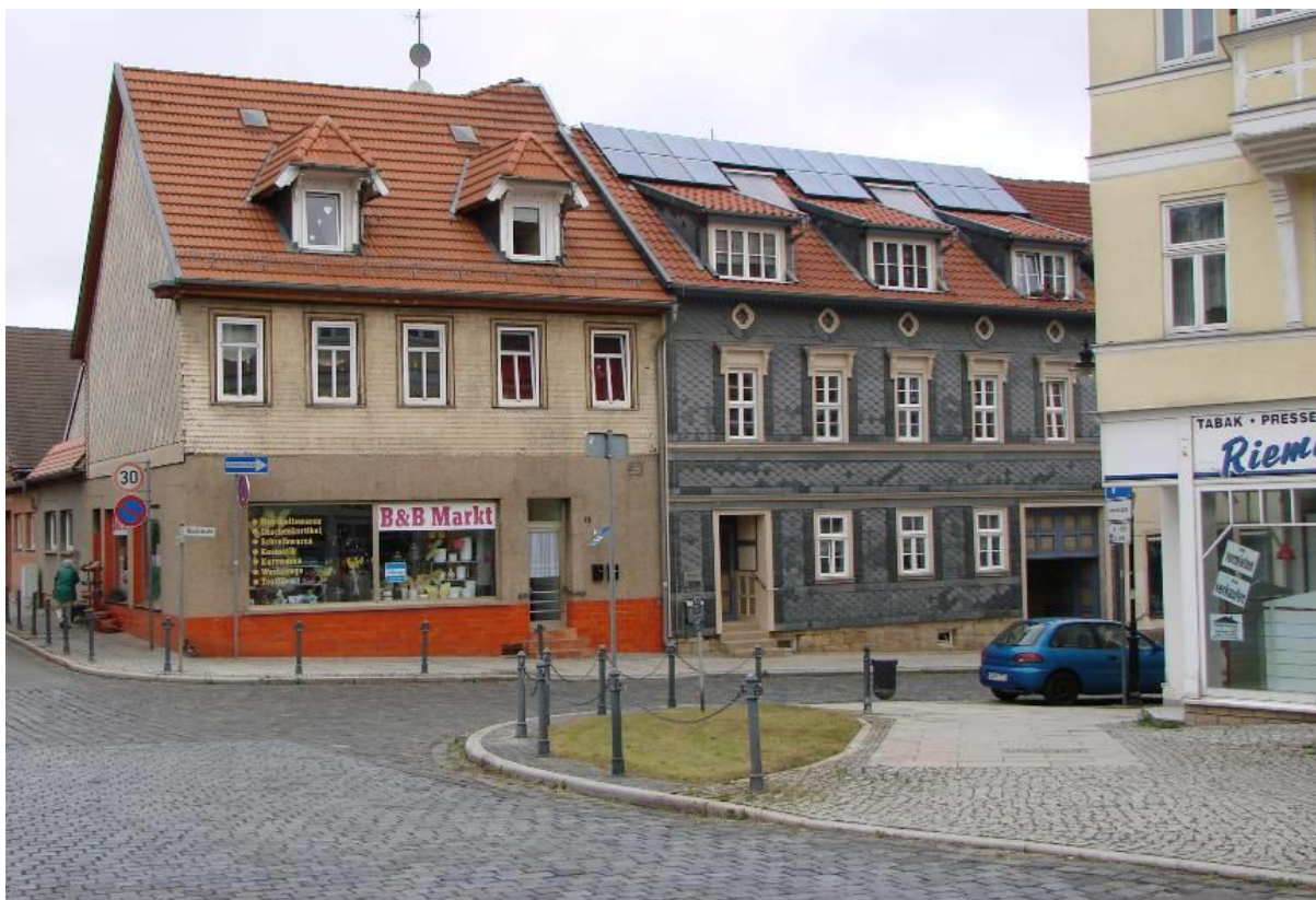
Abbildung 63: Hauptstraße 92, Dachflächenphotovoltaik (Quelle: Holz)
