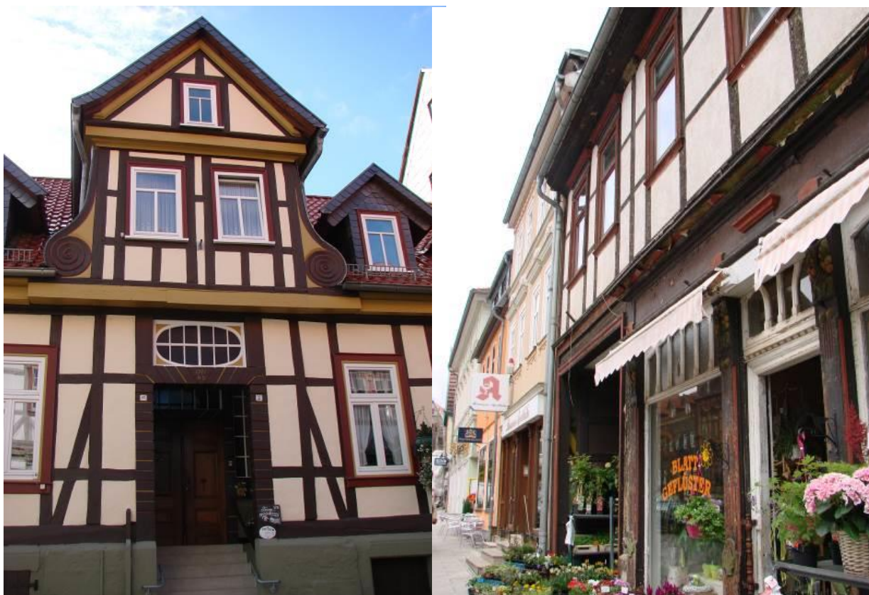
Abbildung 52: links: Eingang, Hauptstraße; rechts: Ladenzeile mit Holzelementen, Hauptstraße (Quellen: Holz)
