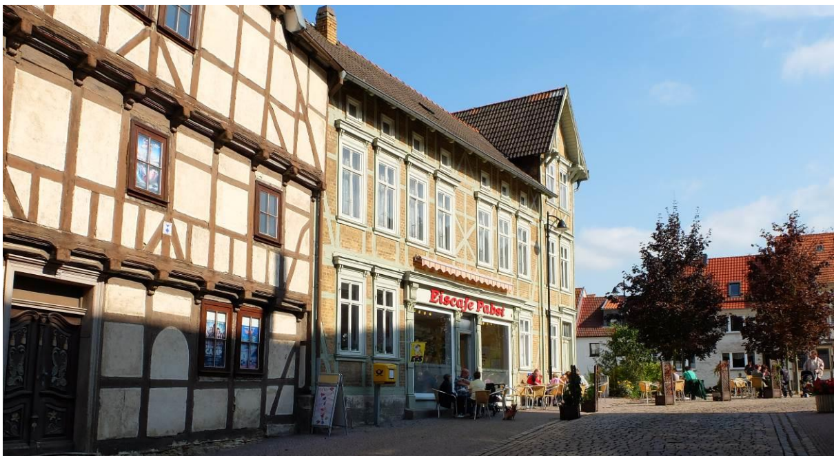
Abbildung 56: ziegelschichtiges Sichtfachwerk Rathausplatz (Quelle: DSK)
