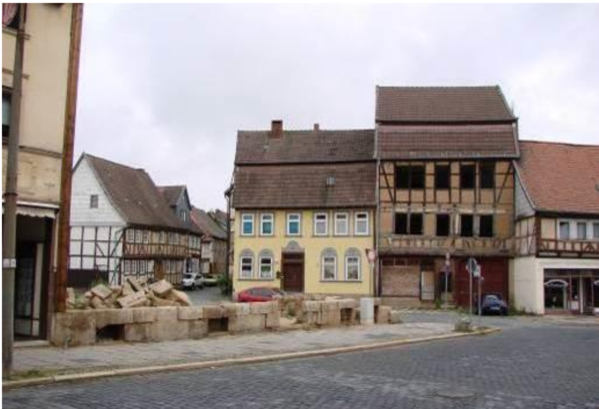
Abbildung 46: Leerstand Hauptstraße - Weberstraße (Quelle: Holz)
